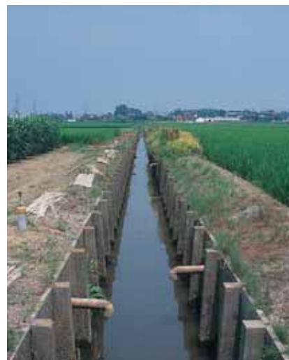
【農業用排水路】
